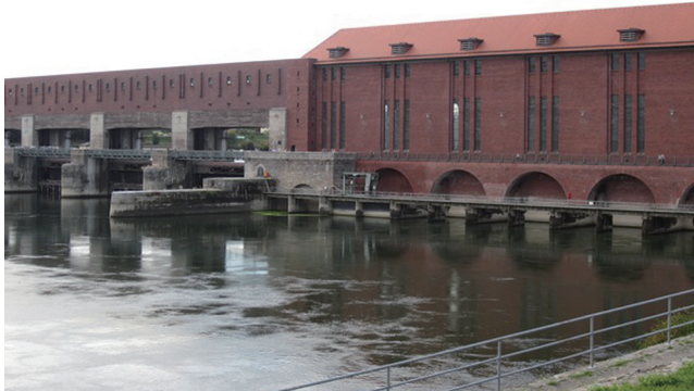
一般公開されるパッサウ北部の水力発電所
